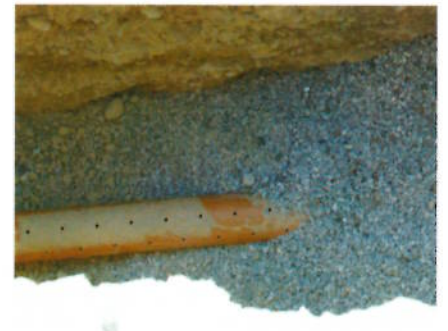
تركيب نظام تصريف المياه الزائدة في التجربة في الموقع الحقلي في منطقة الرمس بسلطنة عمان والتي زرعت فيه لاحقاً بعض أصناف الشعير خلال شهر ديسمبر
