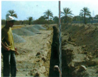
تركيب نظام تصريف المياه الزائدة في التجربة في الموقع الحقلي في منطقة الرمس بسلطنة عمان والتي زرعت فيه لاحقاً بعض أصناف الشعير خلال شهر ديسمبر
