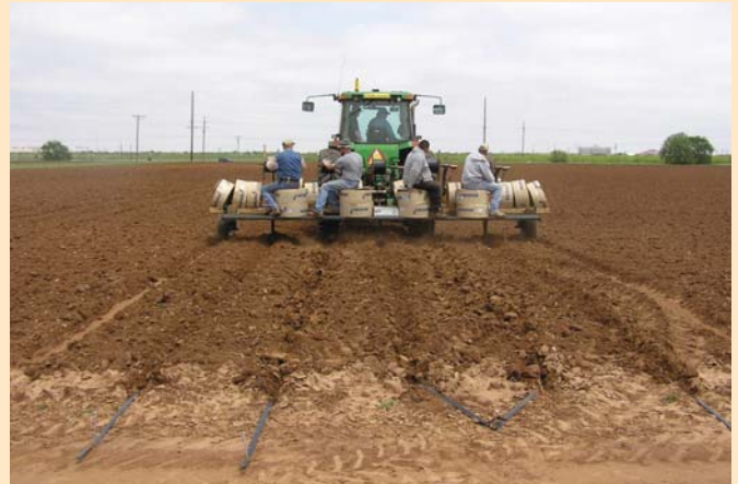
تركيب شبكة الري تحت السطحي بالتنقيط باستخدام الجرار الزراعي
